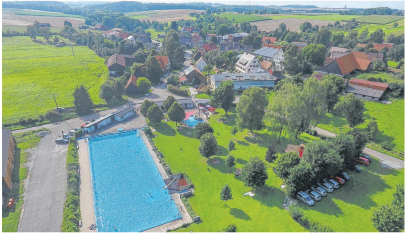
Dieses Drohnfoto zeigt das Freibad Unteraspach. Es liegt idyllisch am Ortsrand. Die Gemeinde Ilshofen informiert sich bei Experten über verschiedene Möglichkeiten, das Bad zu sanieren und aufzuwerten. Foto: Ufuk Arslan
